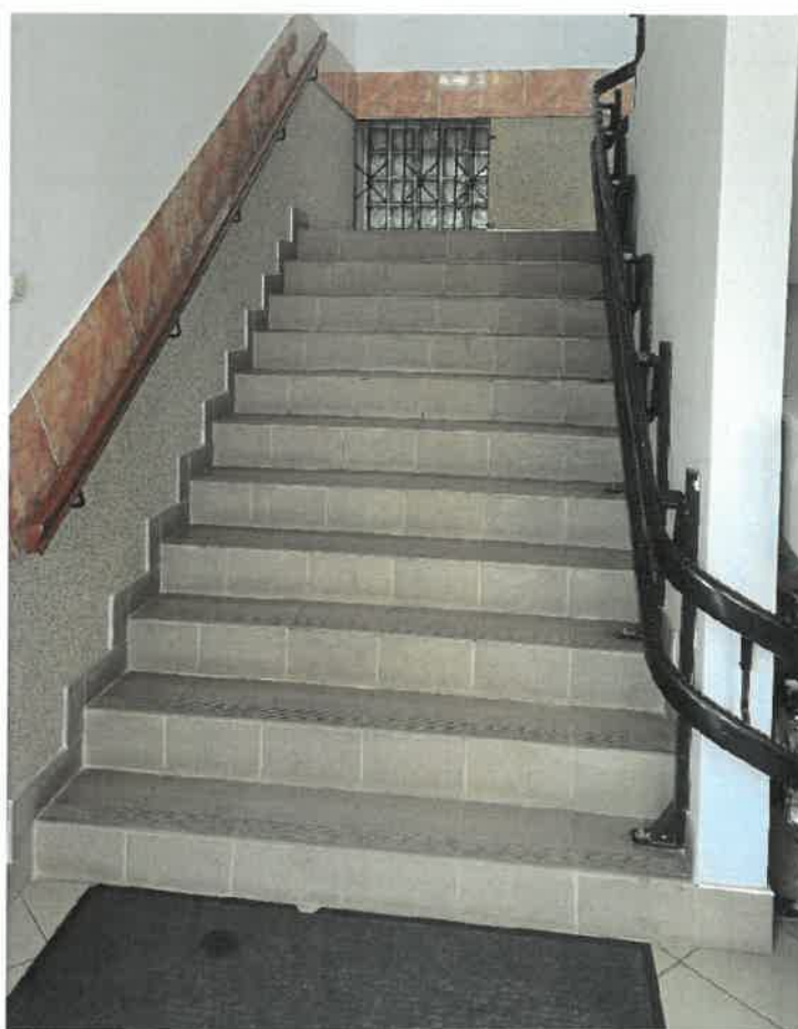
Fot. 2. Widok pierwszego biegu schodów
