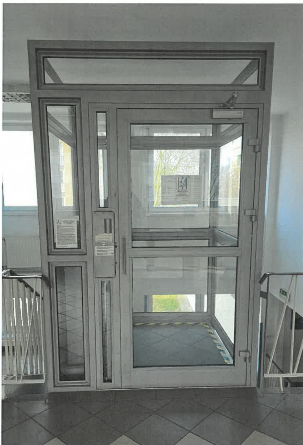
Fot. 2. Widok istniejącego szybu na piętrze
