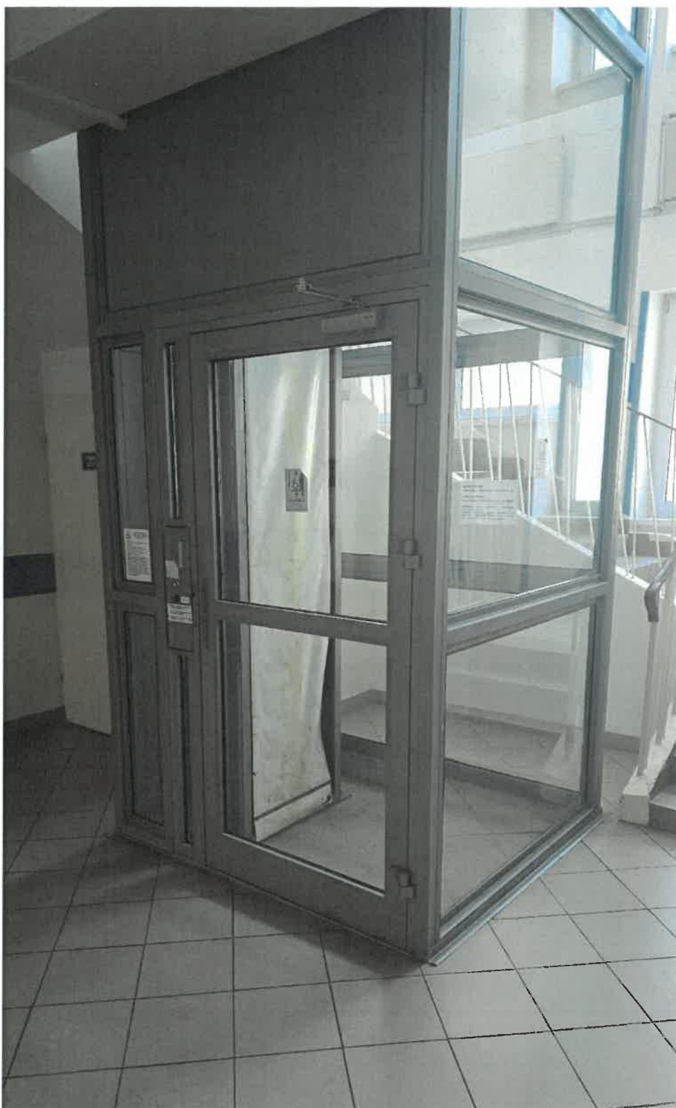
Fot. 1. Widok istniejącego szybu na parterze
