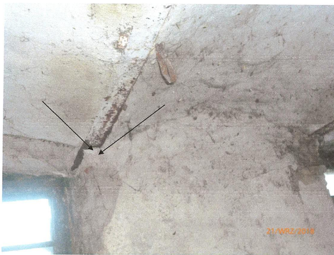
Nieprawidłowe oparcie belki stalowej przy ościeżach okiennych
