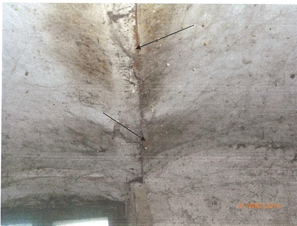
Skorodowana belka stalowa stropu nad piwnicą.
