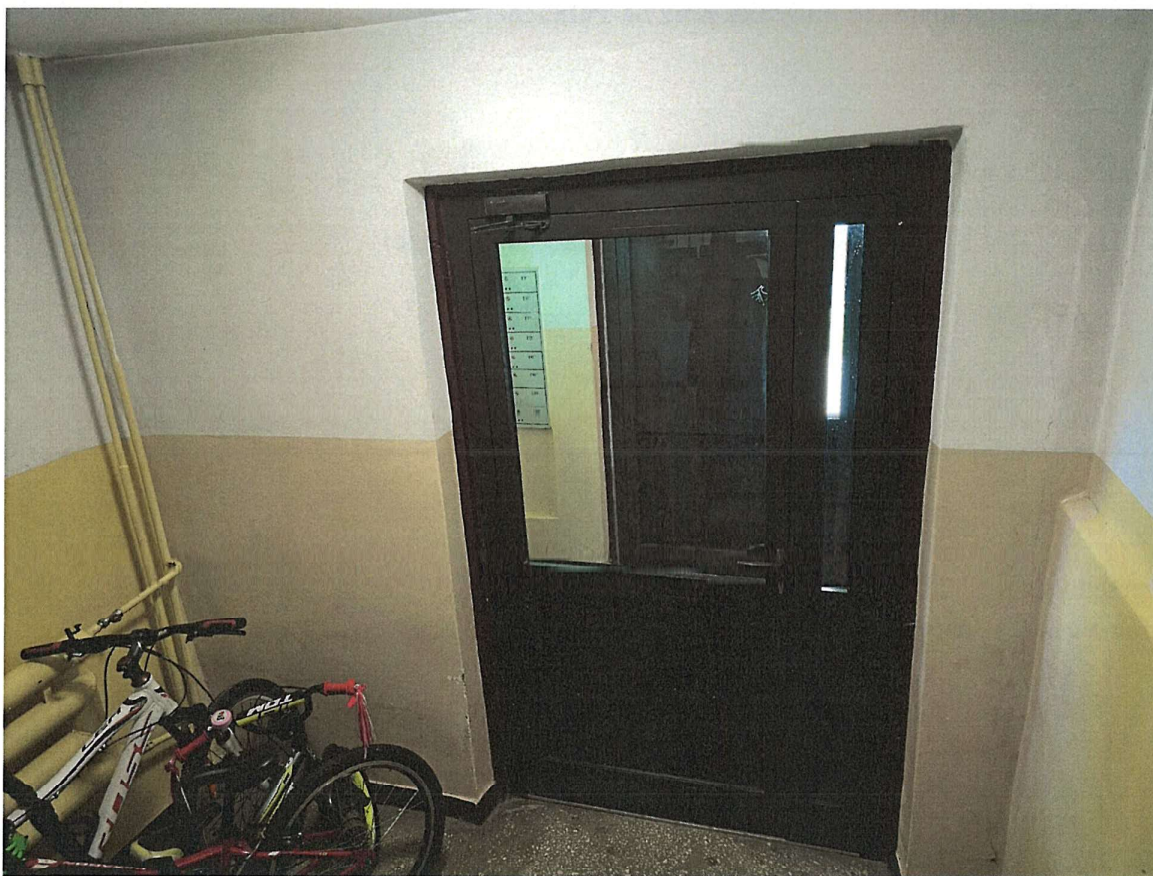
Fot. 1. Widok na drzwi wewnętrzne kl. 3 od strony klatki schodowej.
