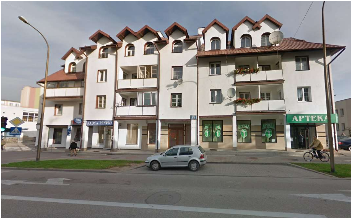
Fot. 1. Widok budynku od strony południowej
