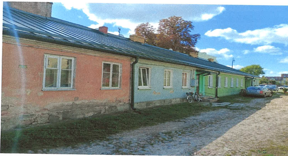
Fot. 1. Budynek oficyny parterowej usytuowany na działce o nr geod 11466/5
