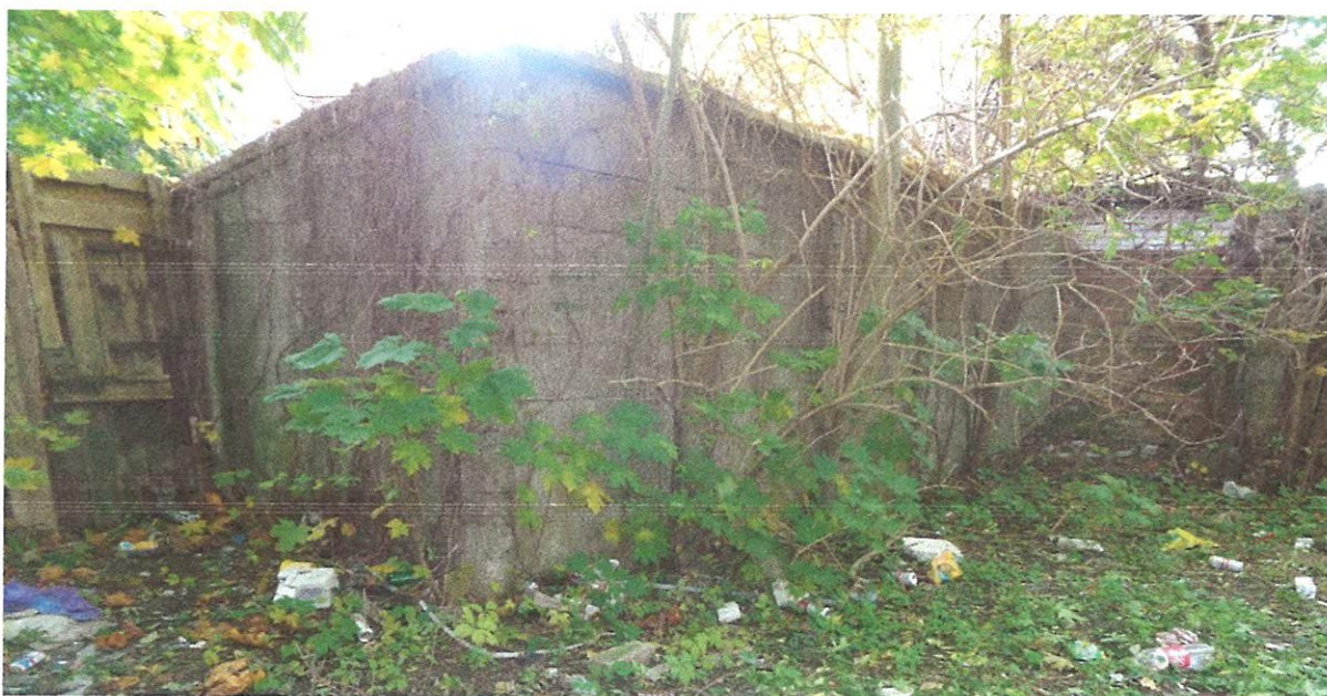
Fot. 2. Budynek gospodarczy nr 3
