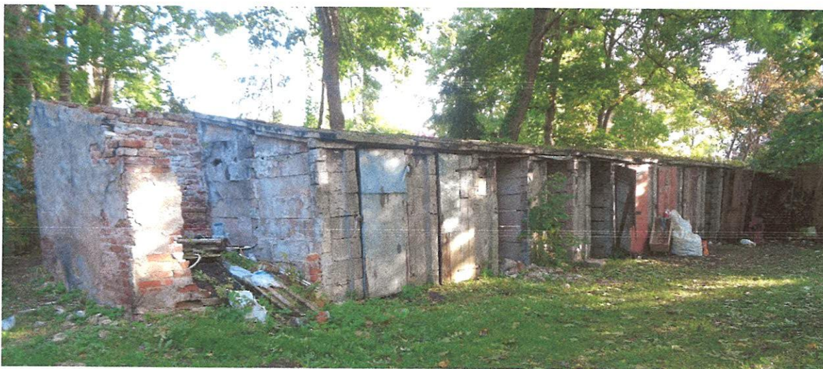
Fot. 2. Budynek gospodarczy nr 2
