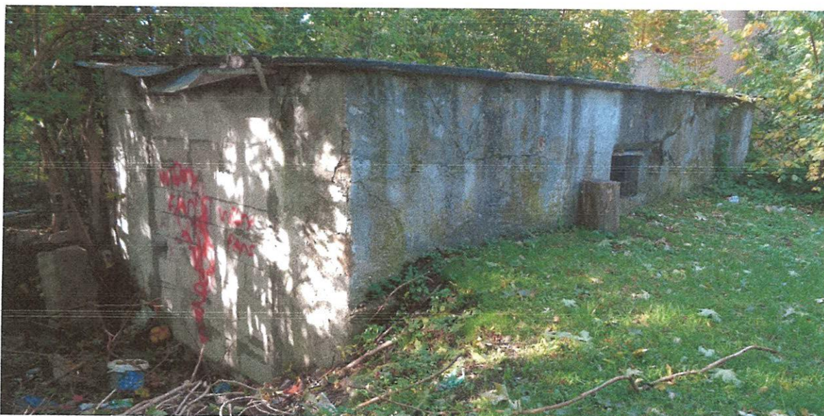
Fot. 1. Budynek gospodarczy nr 1
