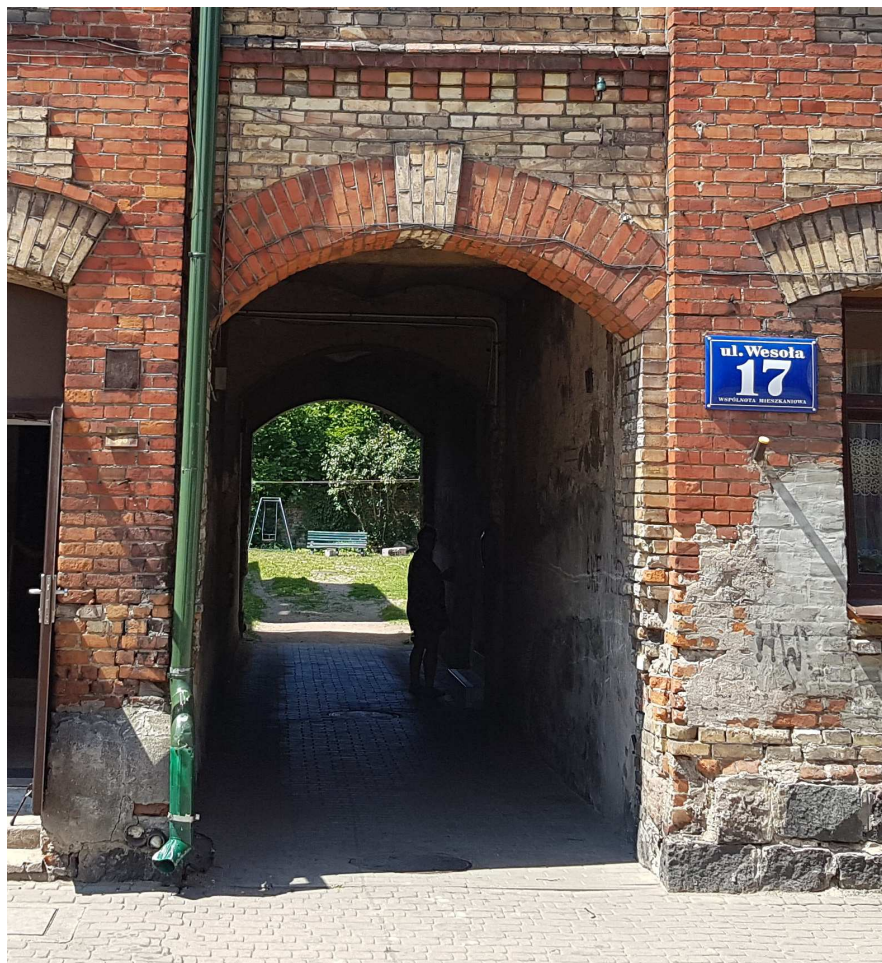
Ubytki cegły w przejeździe bramowym
