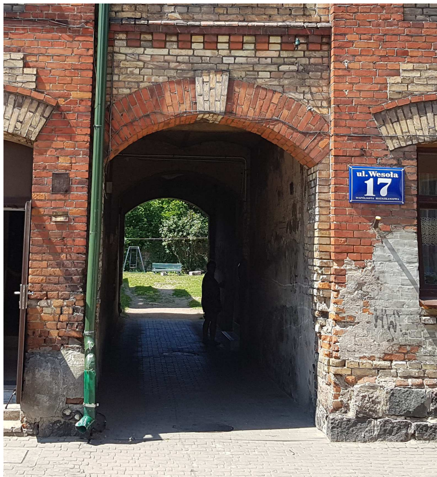
Ubytki cegły w przejeździe bramowym
