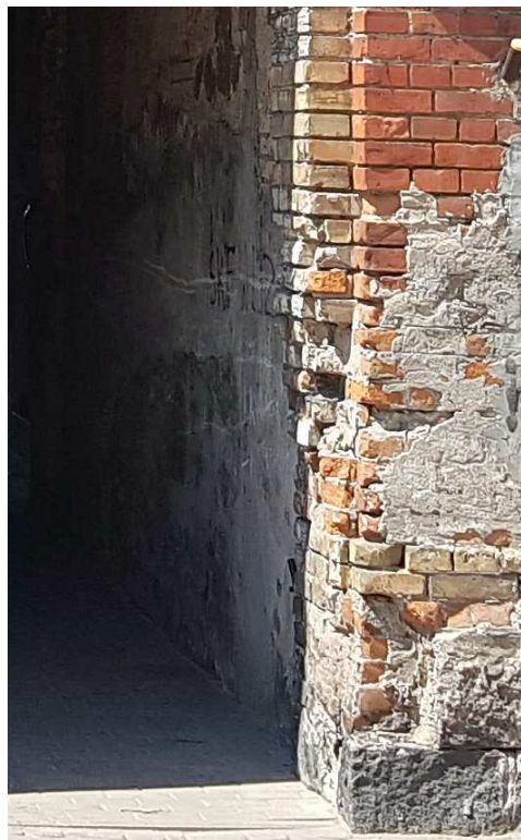
Ubytki cegły w przejeździe bramowym
