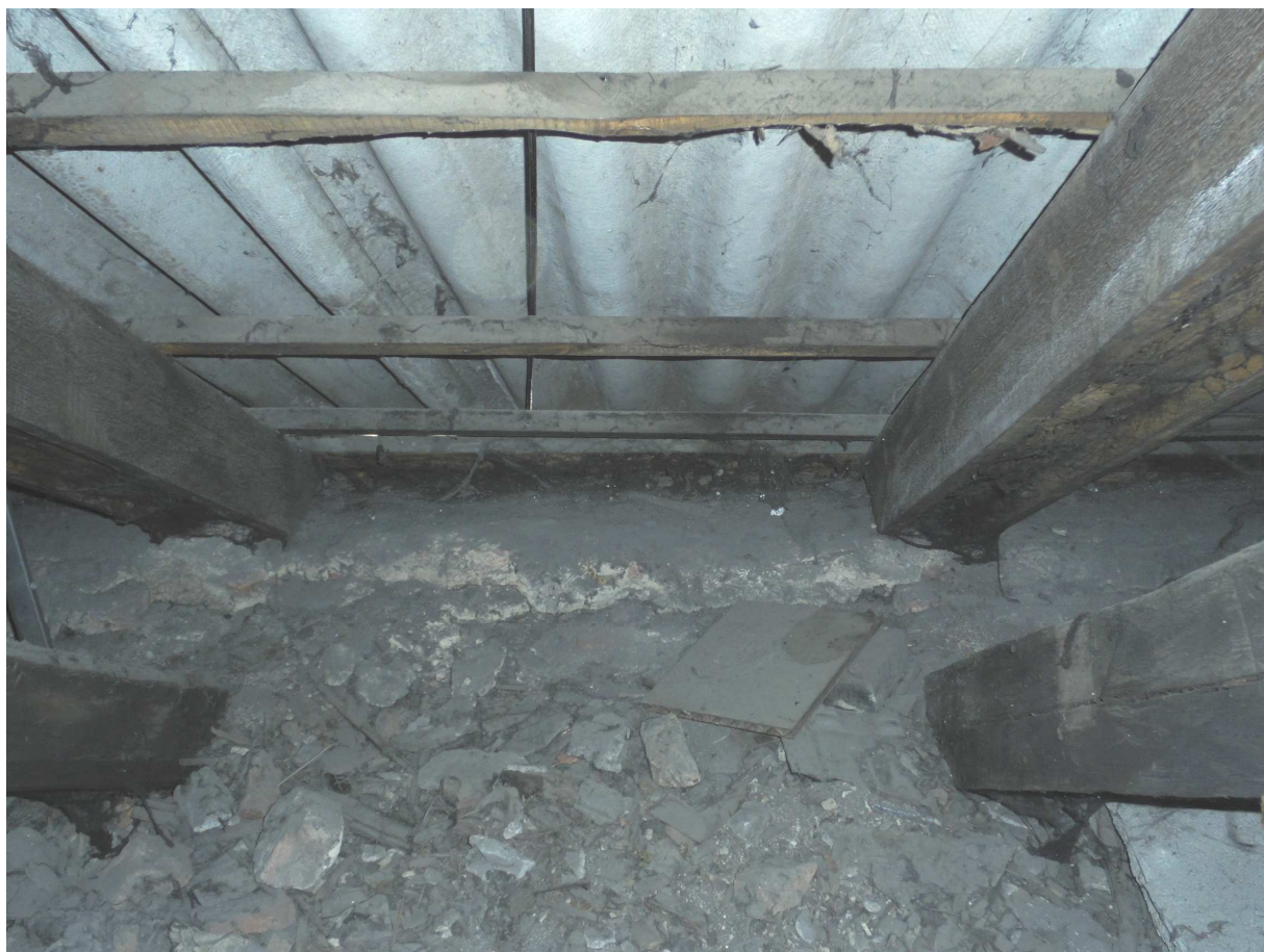
Widok oparcia krokwi i przesuwnic na murze
