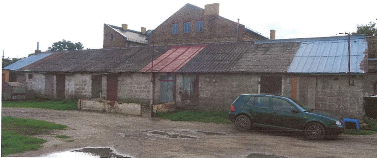
Fot. 1. Budynek gospodarczy usytuowany na działce o nr geod 11126
