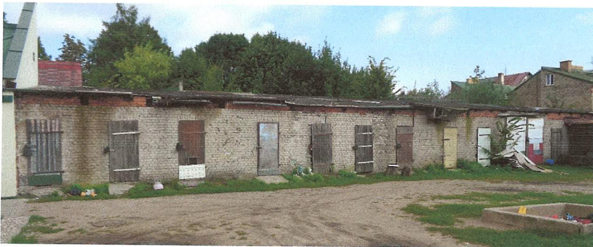
Fot. 3. Budynek gospodarczy usytuowany na działce o nr geod 11125/1
