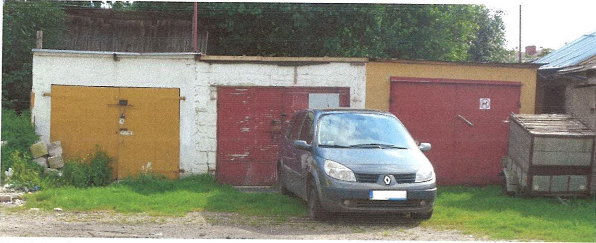
Fot. 2. Budynek garażowy usytuowany na działce o nr geod 11126
