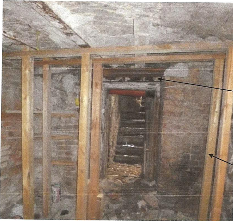
Fot. nr 1. Pom piwniczne nr 5. Tymczasowe podstemplowanie stropu
