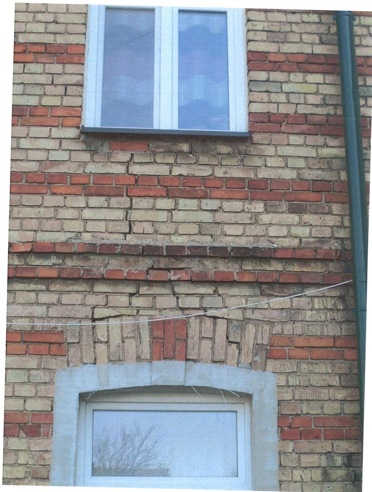
Zdj. 13. Widok uszkodzeń elewacji między siódmymi oknami na elewacji tylnej od strony północnej
