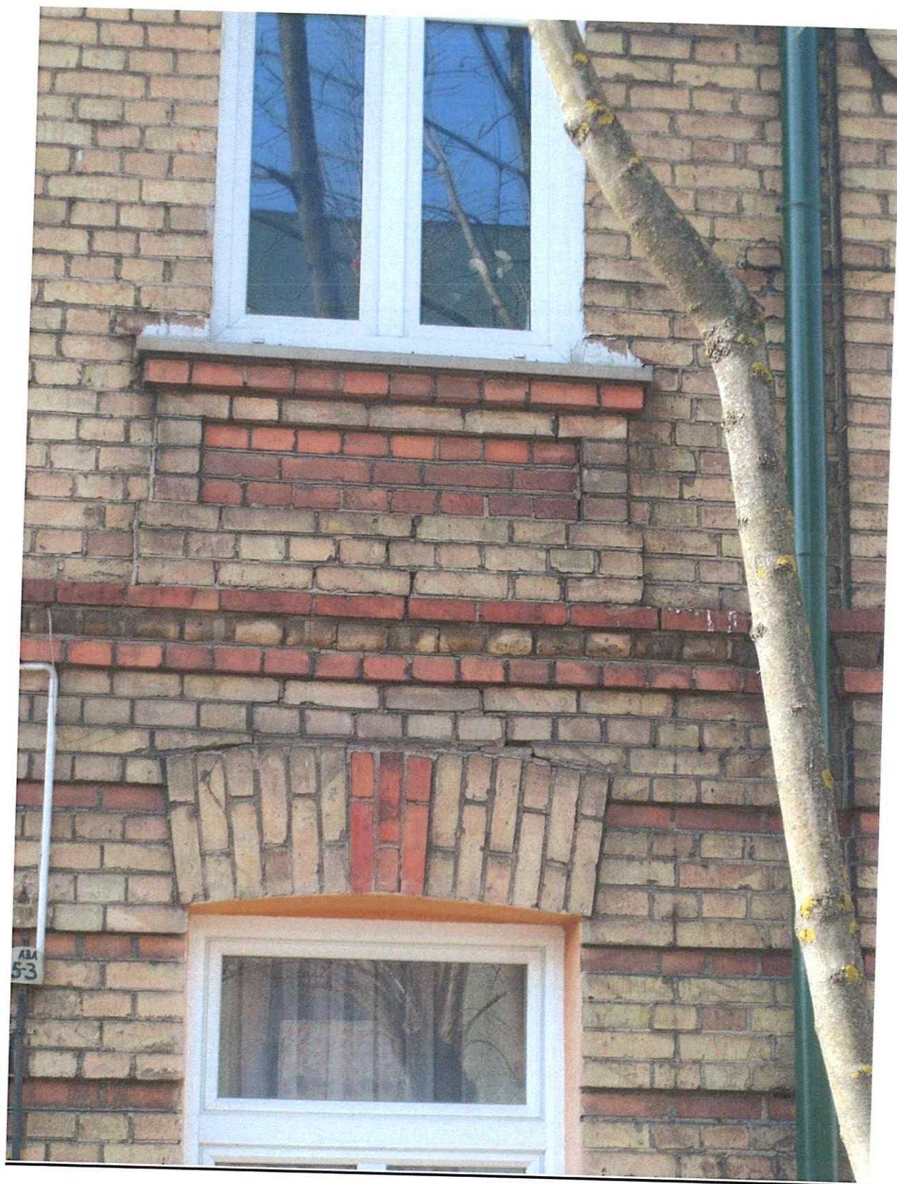
Zdj. 16. Widok uszkodzeń elewacji między pierwszymi oknami na elewacji frontowej od strony północnej.
