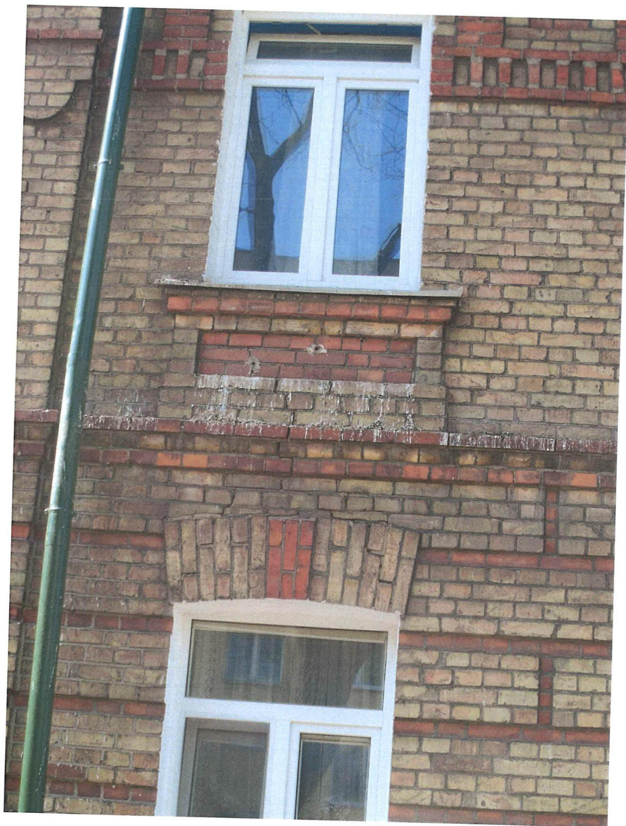
Zdj. 15. Widok uszkodzeń elewacji między siódmym oknami na elewacji frontowej od strony północnej
